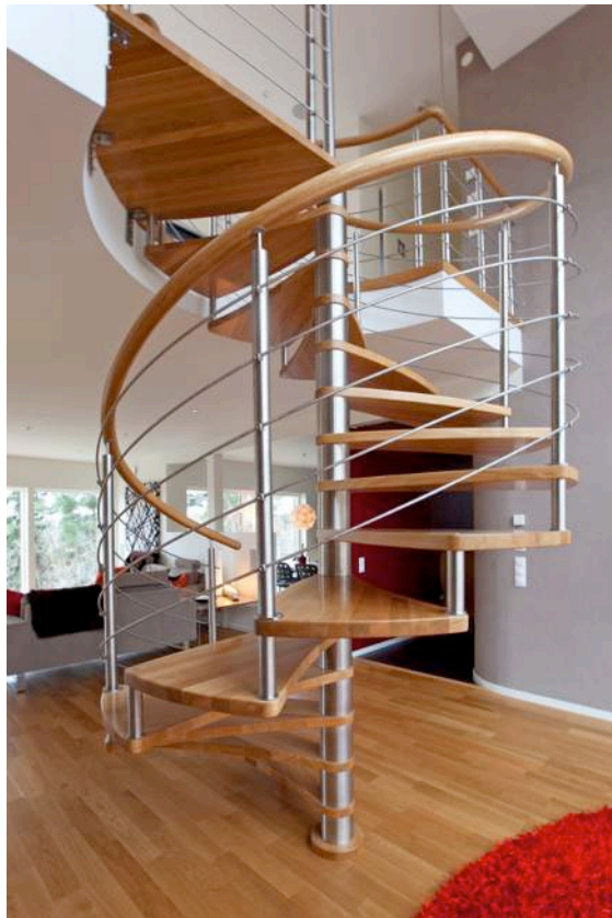
Räcke Marin. Utförande i borstat rostfritt stål. Antal medlöpare 8 mm, 4 styck. Handledare rund profil 50 mm i diameter.
