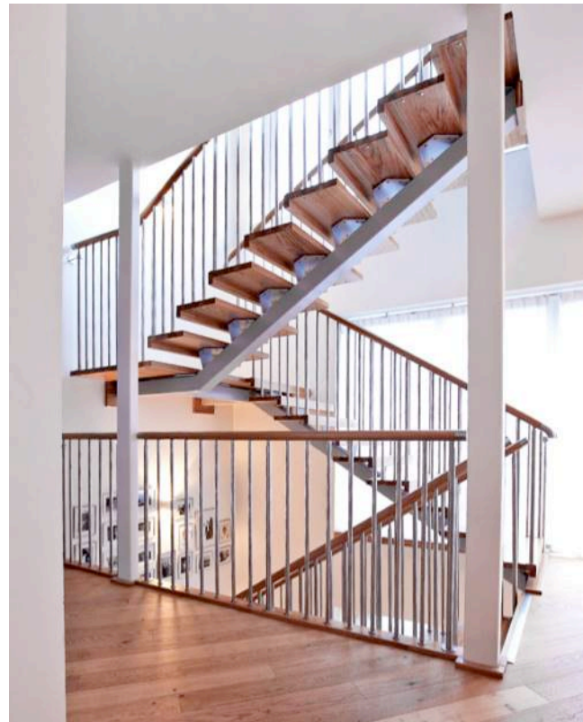
Räcke Funkis. Utförande i borstat rostfritt stål. Handledare (överliggare) profil rund 50 mm i diameter. Avslut handledare hylsa rak/välvd i borstat rostfritt stål.
