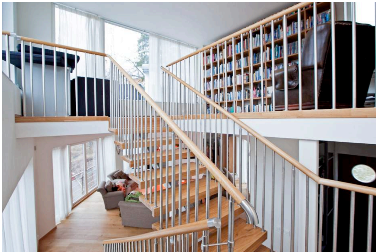
Räcke Funkis. Utförande i borstat rostfritt stål. Handledare (överliggare) profil rund 50 mm i diameter. Avslut handledare hylsa rak/välvd i borstat rostfritt stål.
