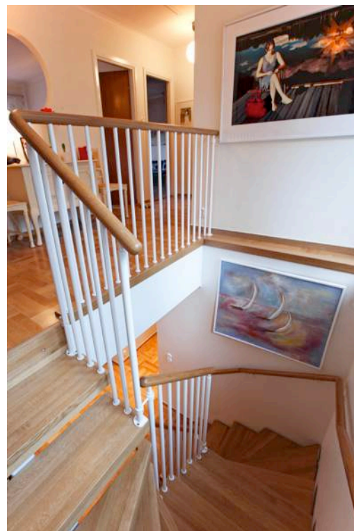
Räcke Funkis. Utförande i pulverlackat stål, RAL kulörschema. Handledare (överliggare) profil rund 50 mm i diameter.
