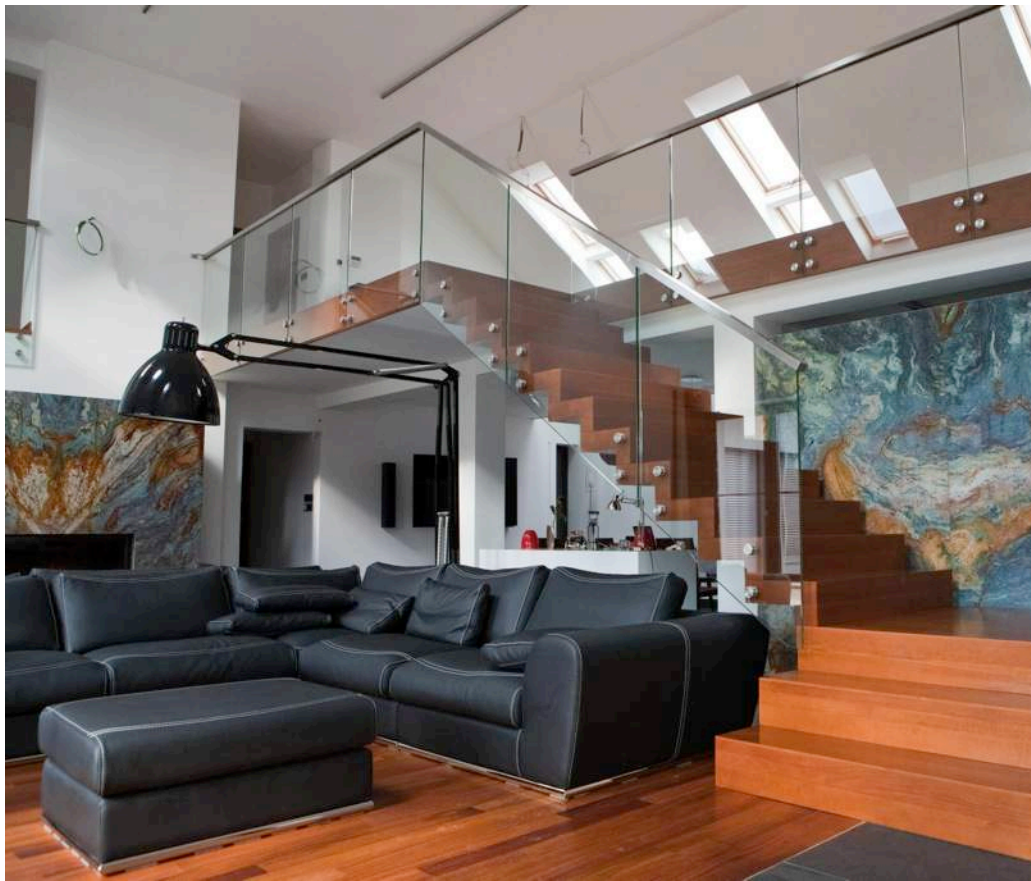
Räcke Glas 13 mm (härdat & laminerat). Handledare (överliggare) i utförande borstat rostfritt stål, profil fyrkant.
