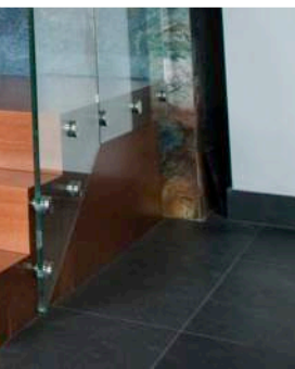
Räcke Glas 13 mm (härdat & laminerat). Handledare (överliggare) i utförande borstat rostfritt stål, profil fyrkant.
