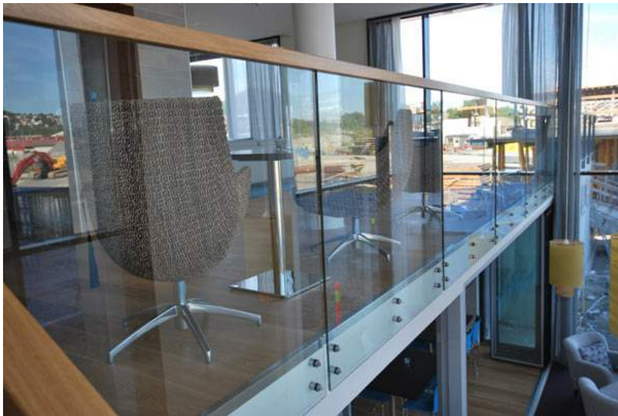
Räcke Glas 13 mm (härdad & laminerat). Handledare (överliggare) i utförande i trä, profil fyrkant.
