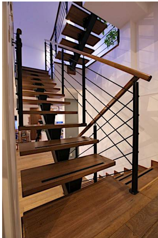
Räcke Marin. Utförande i pulverlackat stål, RAL kulörschema. Antal medlöpare 8 mm, 5 styck. Handledare fyrkantsprofil med översida välvd.
