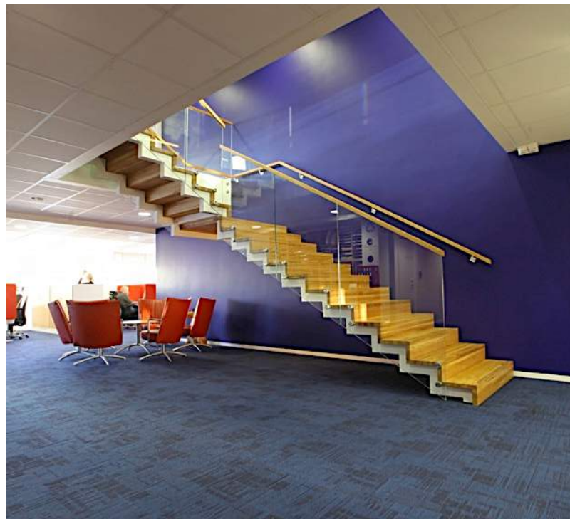
Kontor. L-formad tvåbalkstrappa med räcke Marin. Underliggande balkar i pulverlackat stål, RAL kulörschema. Profil balkar zigzag. Sätt- & plansteg i semi matt lackad ek. Sidmonterat glasträcke 13 mm – härdad och laminerat. Överliggare (handledare) i 50 mm fyrkantsprofil.
