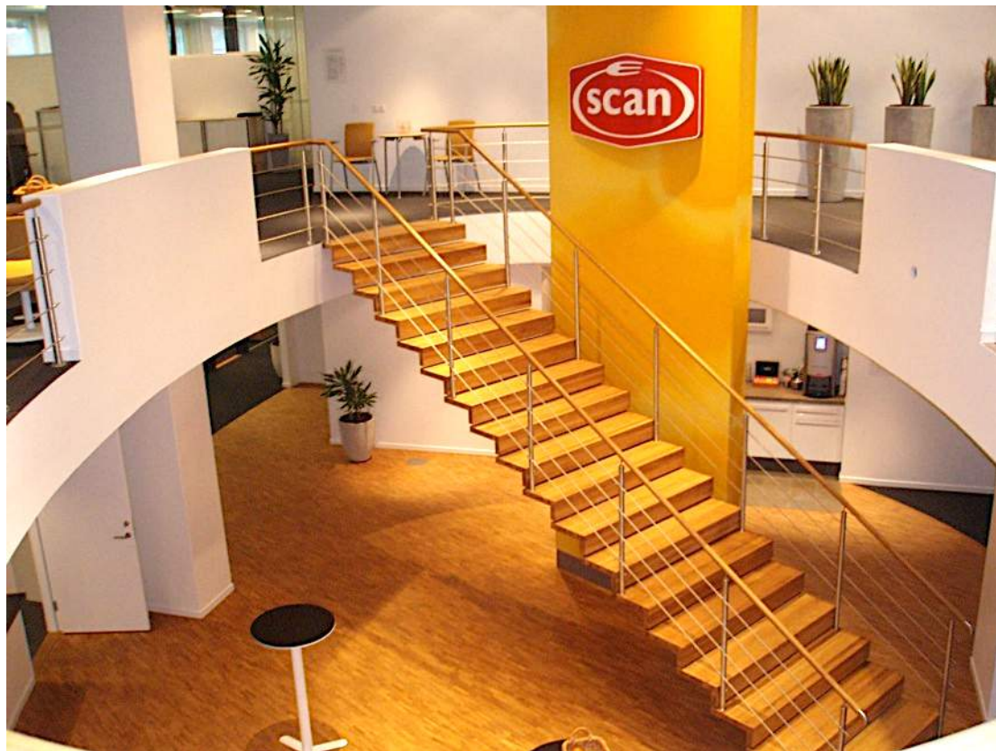
Kontor. Rak enbalkstrappa med fribärande underliggande balk pulverlackad RAL kulörschema. Balkens profil zigzag. Sätt- & plansteg i semi matt lackad ek. Räcke i trappa samt runt bjälklagsöppning modell Marin. Handledare räcke rundstav 50 mm i diameter.
