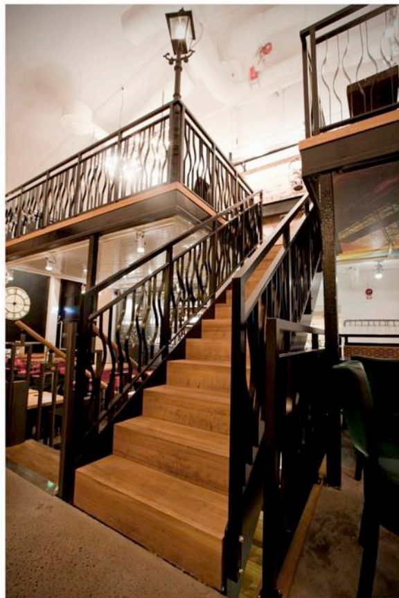
Restaurang. Två trappor – rak respektive L-formad – modell Nordic Light med sidovangstycken i pulverlackat stål RAL kulörschema. Sätt- & plansteg i semi matt lackad ek. Räcke och handledare modell smide pulverlackade RAL kulörschema.
