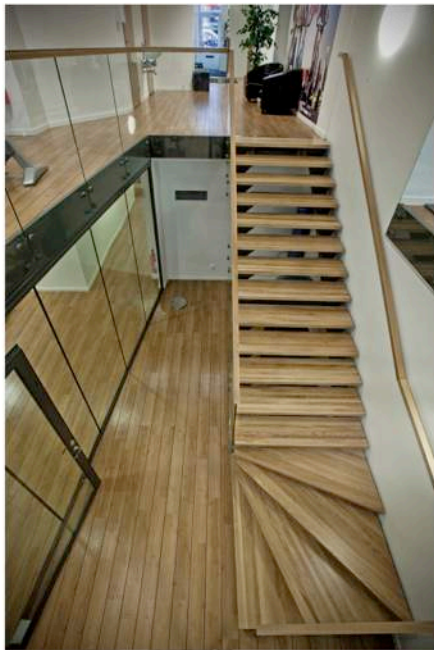
Gym. L-formad tvåbalkstrappa med sidmonterat glasträcke 13 mm – härdat och laminerat. Underliggande balkar profil rak, pulverlackade RAL kulörschema. Steg i semi matt lackad ek. Överliggare (handledare) i 50 mm profil fyrkant, utförande och finish samma som steg.
