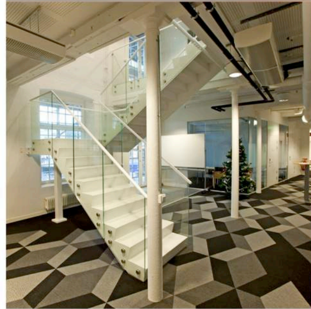
Kontor. U-formad trappa inklusive vilplan för kontorsmiljö. Trappa tillverkad i stål. Ytskikt pulverlack i RAL kulörschema. Sidmonterat glasträcke 13 mm – härdad och laminerat. Överliggare (handledare) i 50 mm rundstav täckmålat NCS.
