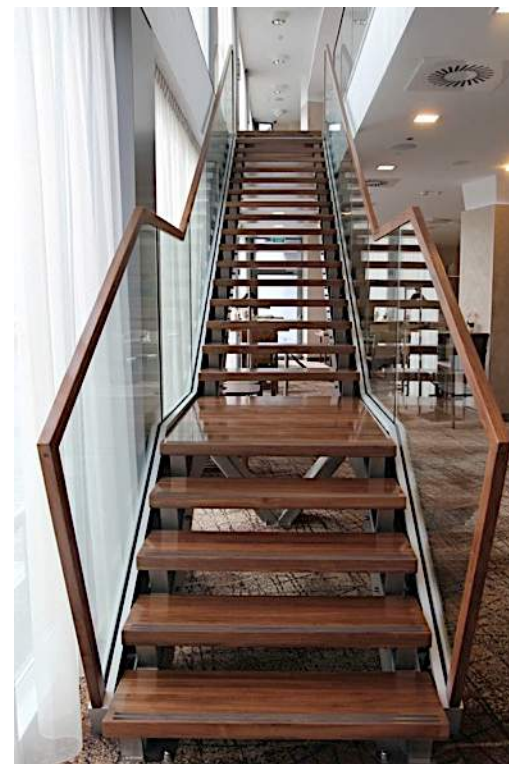
Hotell. Rak trappa modell Nordic Light inklusive vilplan. Sidovangstycken i borstat rostfritt stål. Steg i semi matt lackad valnöt. Räcke i trappa samt runt bjälklagsöppning glasträcke 13 mm – härdat och laminerat. Handledare räcke fyrkantsprofil 50 x 50 mm.
