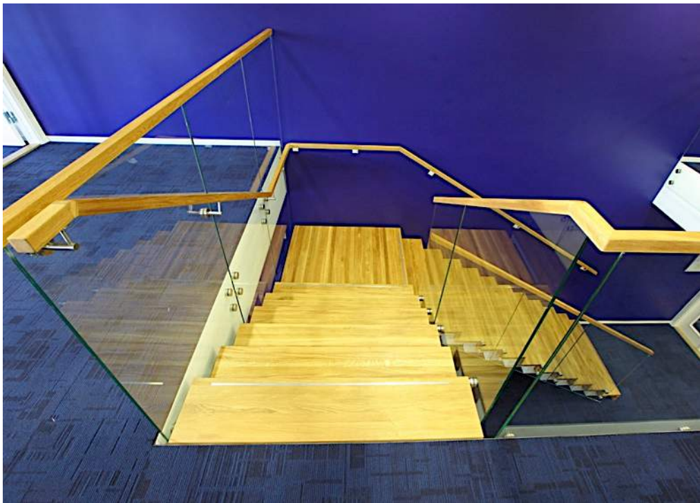
Kontor. L-formad tvåbalkstrappa med räcke Marin. Underliggande balkar i pulverlackat stål, RAL kulörschema. Profil balkar zigzag. Sätt- & plansteg i semi matt lackad ek. Sidmonterat glasträcke 13 mm – härdad och laminerat. Överliggare (handledare) i 50 mm fyrkantsprofil.
