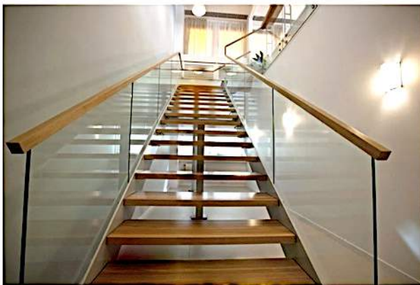
Kontor. L-formad trappa modell Nordic Light inklusive vilplan. Sidovangstycken i pulverlackat stål RAL kulörschema. Steg i semi matt lackad ek. Räcke i trappa samt runt bjälklagsöppning glasträcke 13 mm – härdat och laminerat. Handedare räcke fyrkantsprofil 50 x 50 mm.
