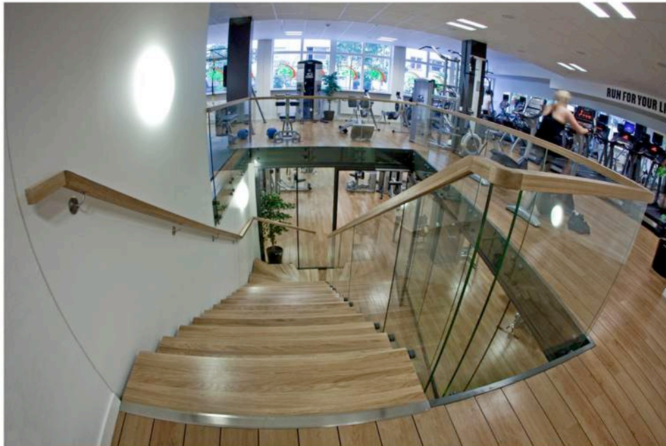
Gym. L-formad tvåbalkstrappa med sidmonterat glasträcke 13 mm – härdat och laminerat. Underliggande balkar profil rak, pulverlackade RAL kulörschema. Steg i semi matt lackad ek. Överliggare (handledare) i 50 mm profil fyrkant, utförande och finish samma som steg.
