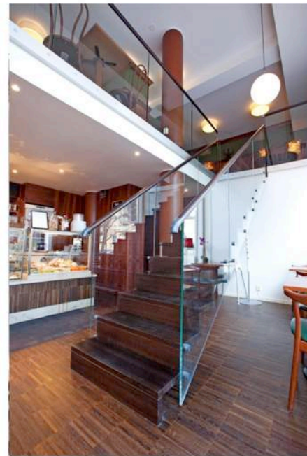
Café. Rak enbalkstrappa med underliggande balk i pulverlackat stål, RAL kulörschema. Profil balk zigzag. Sätt- & plansteg i betsad och semimatt lackad ek. Räcke i trappa samt runt bjälklagsöppning glasträcke 13 mm – härdat och laminerat. Handledare räcke rundstav 50 mm i diameter.
