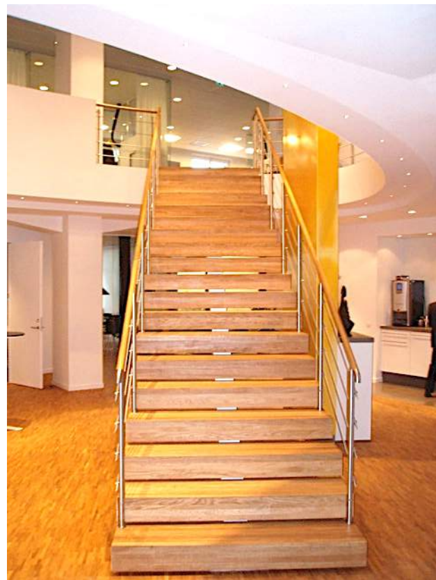
Kontor. Rak enbalkstrappa med fribärande underliggande balk pulverlackad RAL kulörschema. Balkens profil zigzag. Sätt- & plansteg i semi matt lackad ek. Räcke i trappa samt runt bjälklagsöppning modell Marin. Handledare räcke rundstav 50 mm i diameter.
