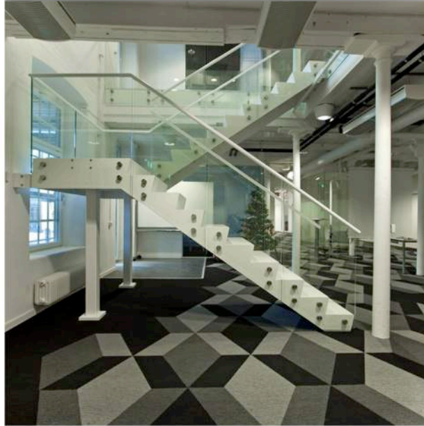
Kontor. U-formad trappa inklusive vilplan för kontorsmiljö. Trappa tillverkad i stål. Ytskikt pulverlack i RAL kulörschema. Sidmonterat glasträcke 13 mm – härdad och laminerat. Överliggare (handledare) i 50 mm rundstav täckmålat NCS.
