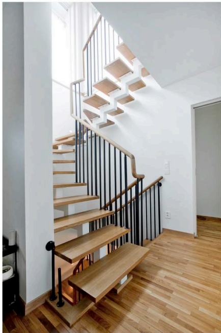
Dubbla U-formade enbalkstrappor med räcke Funkis pulverlackad kulör RAL kulörschema. Steg i semi matt lackad ek. Underliggande balkar zigzag profil, pulverlackade kulör RAL kulörschema. Handledare räcke diameter 50 mm.
