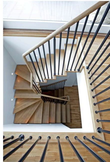
Dubbla U-formade enbalkstrappor med räcke Funkis pulverlackad kulör RAL kulörschema. Steg i semi matt lackad ek. Underliggande balkar zigzag profil, pulverlackade kulör RAL kulörschema. Handledare räcke diameter 50 mm.
