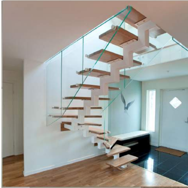
U-formad enbalkstrappa med räcke Glas 13 mm härdat och laminerat. Steg i semi matt lackad ek. Underliggande balk zigzag profil, pulverlackad kulör RAL kulörschema.
