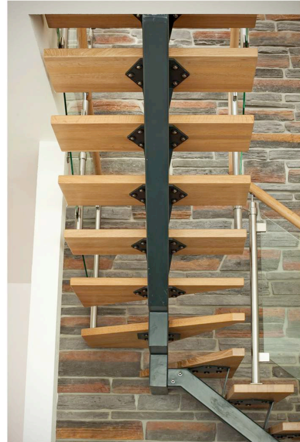
L-formad enbalkstrappa med räcke Glas 4 + 4 mm laminerat. Steg i semi matt lackad ek. Underliggande balk rak profil, pulverlackad kulör RAL kulörschema. Handledare räcke diameter 50 mm.
