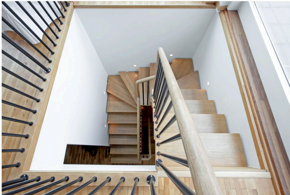
Dubbla U-formade enbalkstrappor med räcke Funkis pulverlackad kulör RAL kulörschema. Steg i semi matt lackad ek. Underliggande balkar zigzag profil, pulverlackade kulör RAL kulörschema. Handledare räcke diameter 50 mm.
